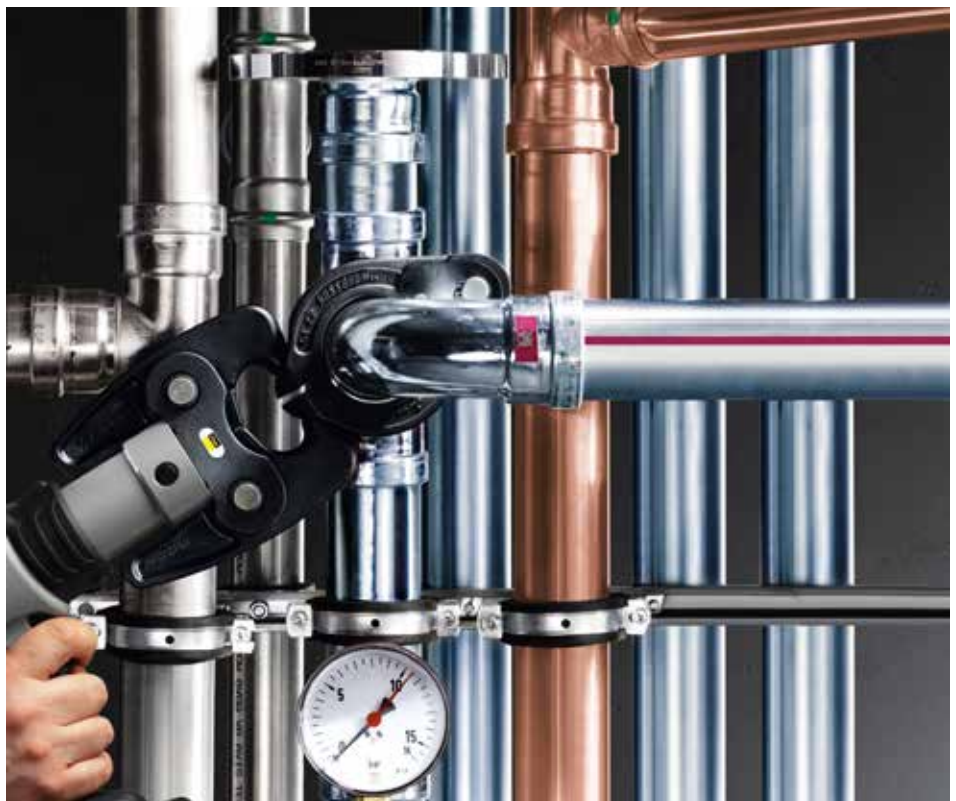
Grote diameters kunnen met de persring eenvoudig geperst worden.
