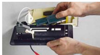
2 Le carter avec le servomoteur est placé sur le cadre d'encastrement et un déclenchement manuel est monté afin de pouvoir déclencher une chasse d'eau en cas de dysfonctionnement.
