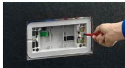
4 La plaque de montage est fixée au réservoir puis la plaque de commande est montée.
