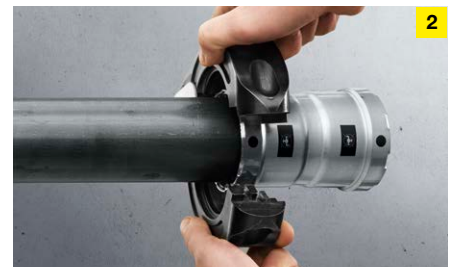
2 Om Megapress-fittingen vanaf 1\frac{1}{4} duim te persen worden uitsluitend persringen met scharniertrekklauw gebruikt. In kleinere maten tussen \frac{3}{8} en 1 duim kunt u kiezen uit zowel persbekken als persringen met scharniertrekklauw.
