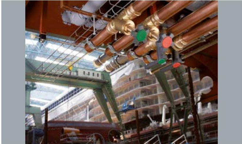
Abb. 151 Seapress XL-Installation mit Kupferrohren und Easytop-Armaturen
