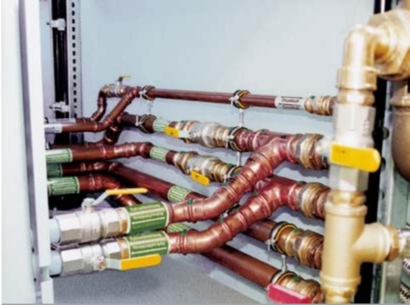
Abb. 149 Kühlwasserkreislauf Hydraulikanlage
