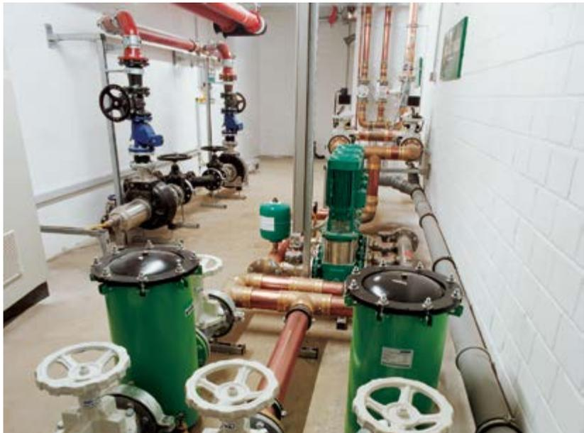
Abb. 150 Aufbereitungsanlage für Nichttrinkwasser
