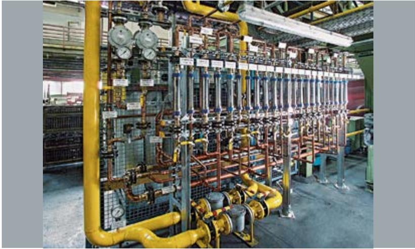
Abb. 152 Verteilerbalken für Technische Gase
