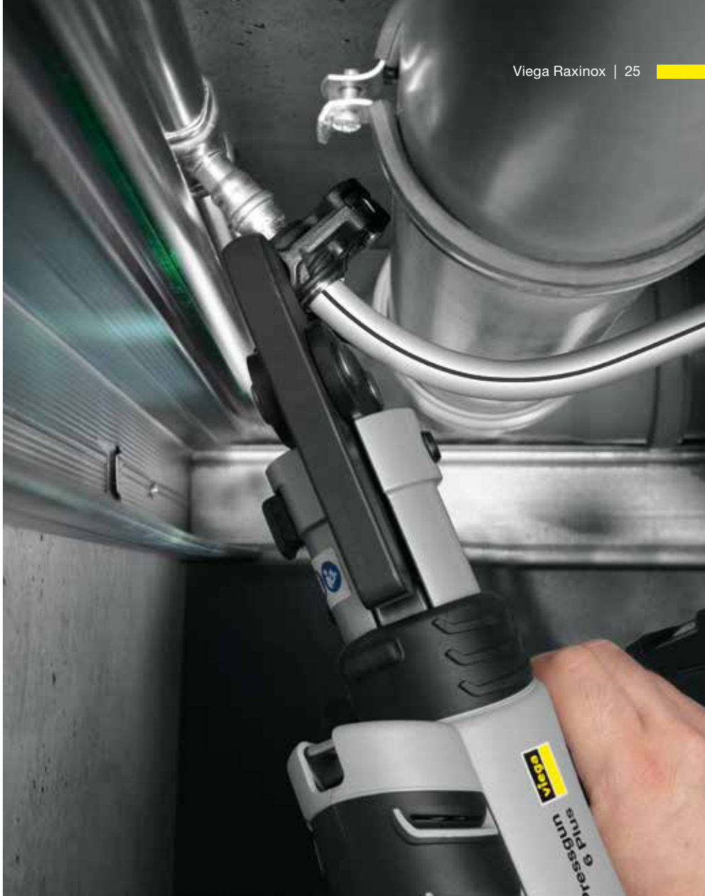
Ideal für verwinkelte Einbausituationen bei der Modernisierung: die Viega Gelenkzugbacke.
